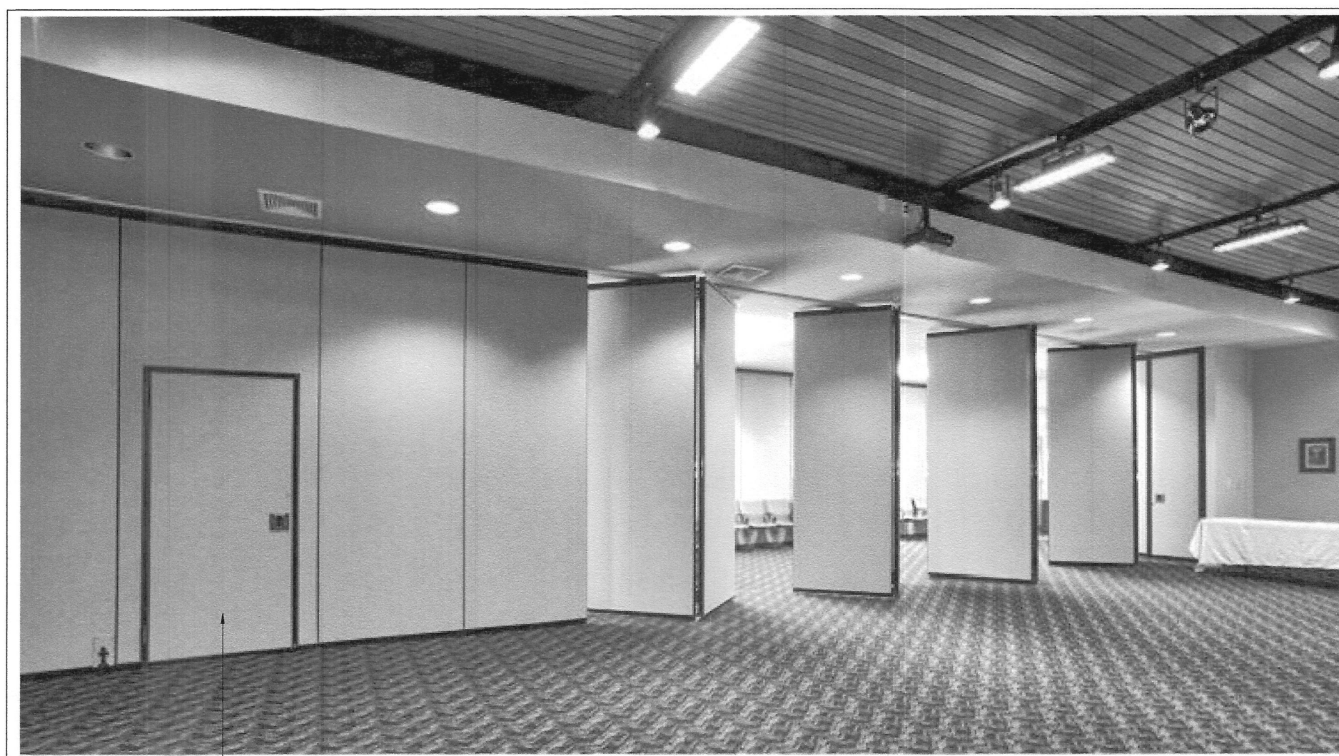
ภาพแสดงทั่วไปในการติดตั้งผนังสำเร็จรูปกันเสียง
